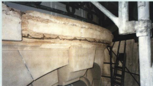
◀ Corniche pierre en rive de terrasse - Goujonnage en fil de laiton pour armer la reprise en mortier de pierre.
