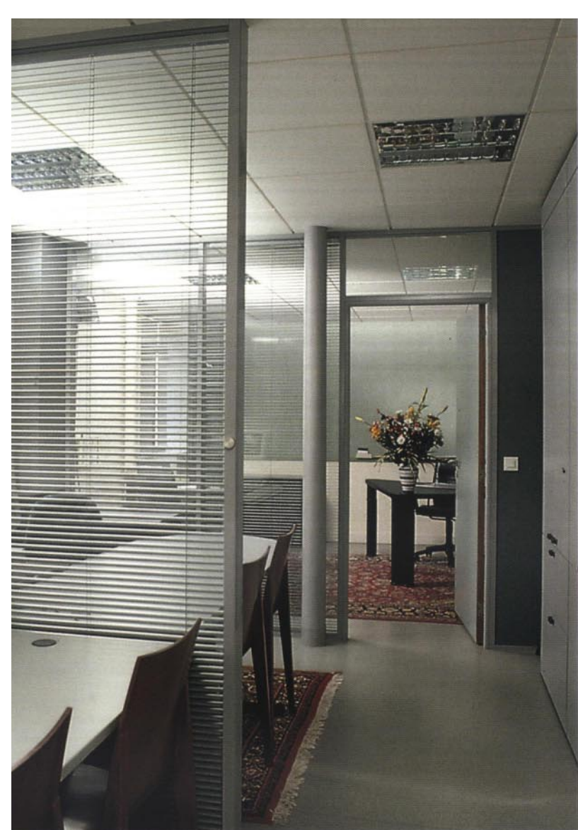
▲ Des espaces distincts qui communiquent - Les bureaux sont séparés par des cloisons vitrées intégrant des stores à lamelles perforées qui permettent d'isoler les postes de travail.
