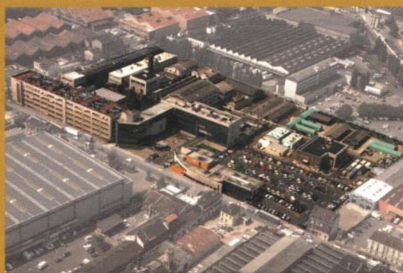
CRA - Centre de recherche d'Aubervilliers - 40 000 m 2
