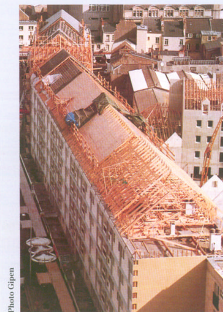
❻ A Cherbourg, la surélévation de ces logements a été réalisée grâce à une solution conçue par le bet Gipen. Elle allie préfabrication et souplesse de conception par une analyse fine de la structure existante.
