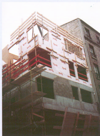
❸ Construit à Paris, ce petit immeuble est constitué d'une structure mixte béton et bois dont l'utilisation résout les problèmes épineux de descentes de charges; G2A architectes, F. Payen.
