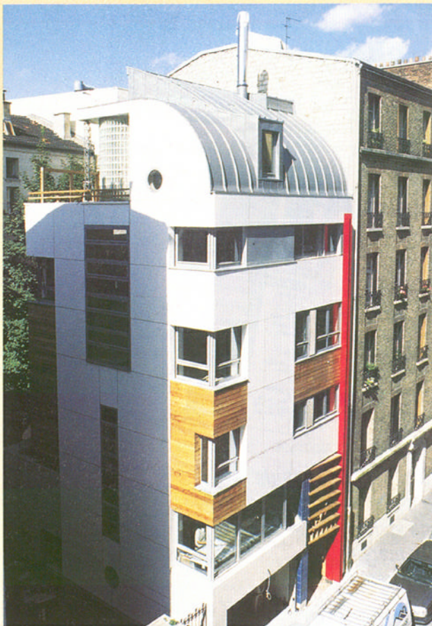
La façade en panneaux stratifiés et en red cedar fait écho à la structure dichotomique du bâtiment
