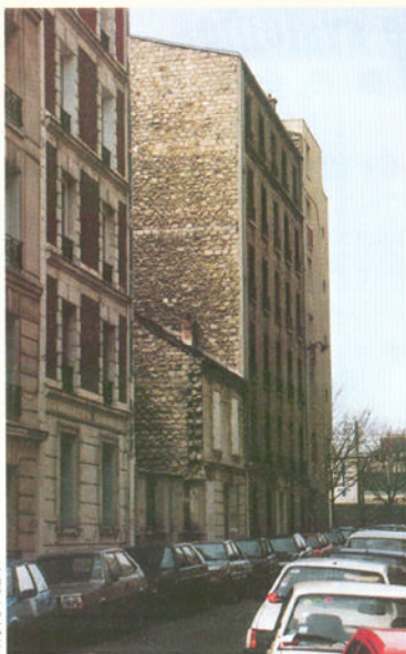
La rue Alfred-Durand-Claye avant les travaux
