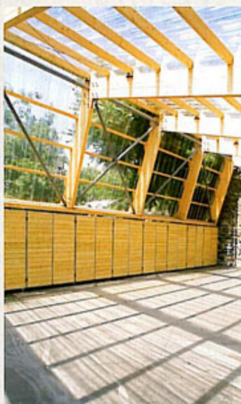
Un brisis composite fait de bois et de métal supporte toute la charge de la structure. Les deux poteaux en béton sont dissimulés à l'intérieur des placards. (Doc. Tabou Photographe)
